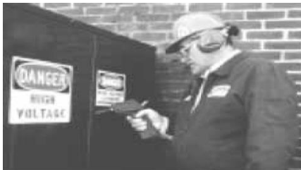
Teste de comutadores de alta tensão, transformadores, etc. para verificar arcos, seguimento e efeito de coroa.
